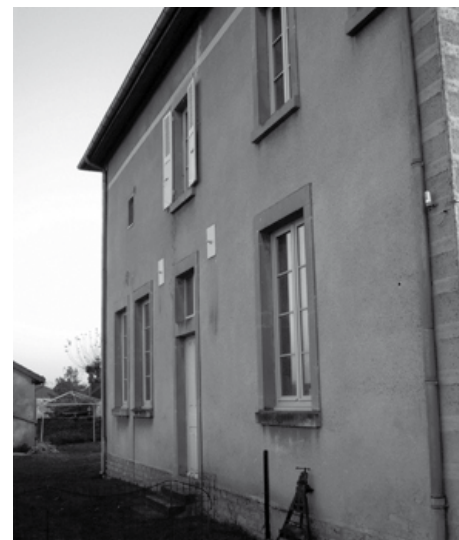
Façade sur laquelle s'est raccrochée l'extension
