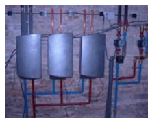
Caches d'isolation des régulations
