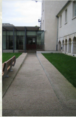
Rampe en site ancien
