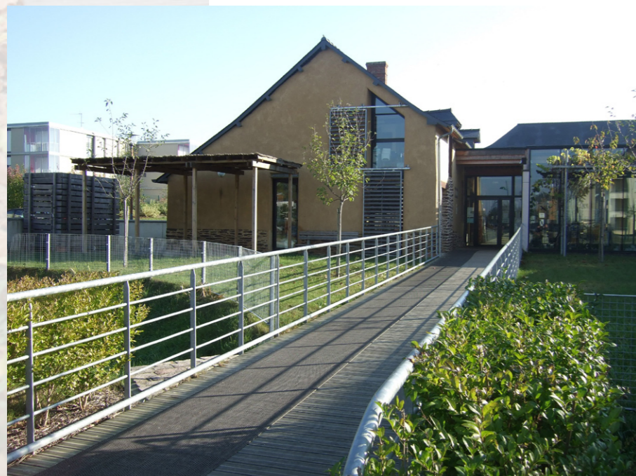
Entrée accessible à tous aménagée lors de la réhabilitation des bâtiments
