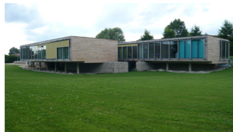
Maison médicale, 2009, Saint-Germain-du-Bois Arcad'26 - Laurent Jannet architecte
