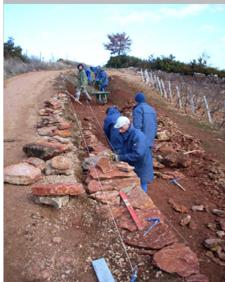
Mur de soutènement d'un chemin, en pierres sèches sur le sentier d'accès au sommet de la Roche.
