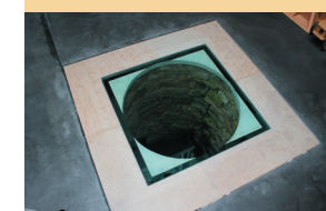
La dalle du rez de chaussée en béton ciré entoure le puits avec un encadrement en pierre de Bourgogne
