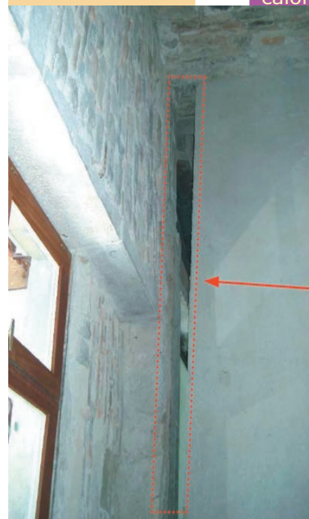
La dalle béton a été cassée aux endroits où elle était non porteuse et désolidarisée du mur extérieur pour supprimer le pont thermique
