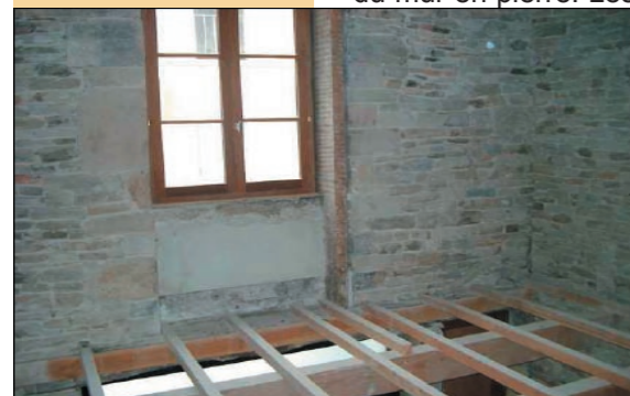
La dalle béton du 1 er étage au-dessus de la cuisine a été cassée et remplacée par un plancher bois isolé par 10cm de ouate de cellulose pour améliorer l'acoustique
