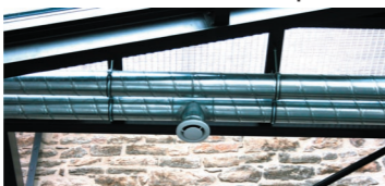
Le passage des conduits de ventilation
