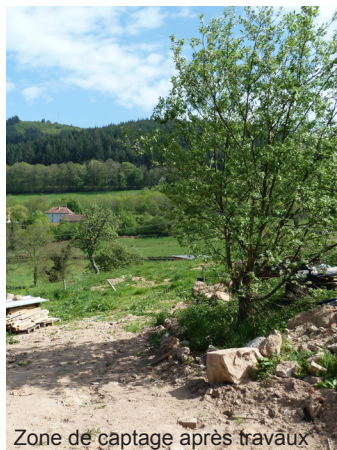
Terrassement pour le captage
