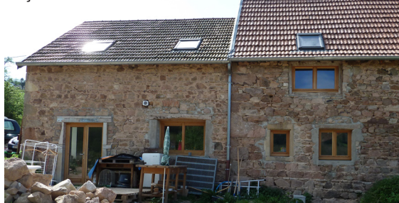
façade est de la maison
