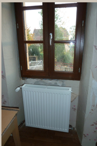
Menuiserie bois remplacée + radiateurs
