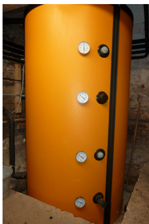
ballon d'hydroaccumulation
