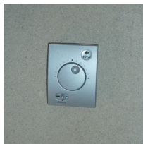
Thermostat programmable placé dans le salon
