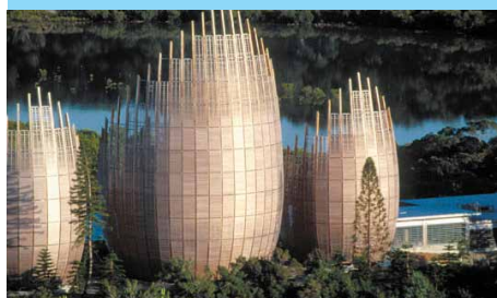
Centre culturel Jean-Marie Tjibaou à Nouméa Renzo Piano architecte
