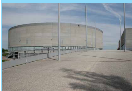
Complexe sportif Le Colisée à Chalon
