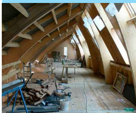
Le bâtiment en chantier
