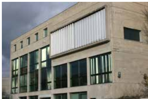
Hôtel de ville de Fontaine-lès-Dijon, CHAUDONNERET Pierre et PÉPIN Louis © CAUE71
