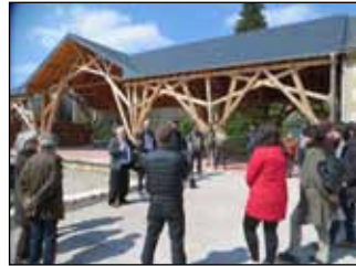
Visite de la halle à Anost, 1 er projet Démonstrateur Bois Massif Central en Morvan
