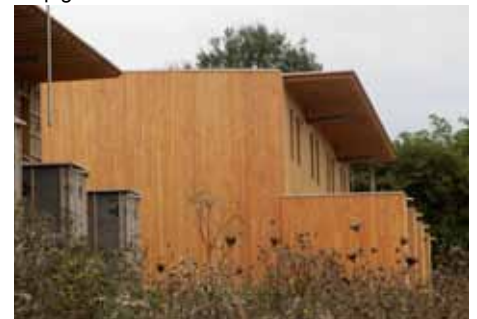
Le pignon ouest du bâtiment 2
