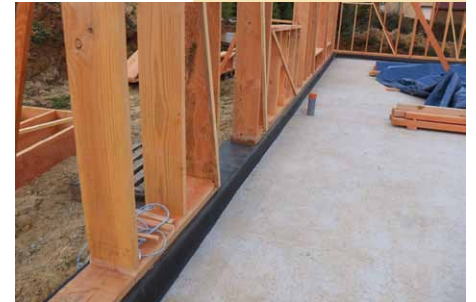
Dalle béton et ossature bois
