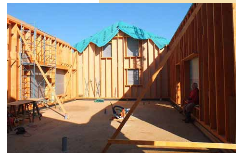
Ossature bois, panneaux de contreventement
