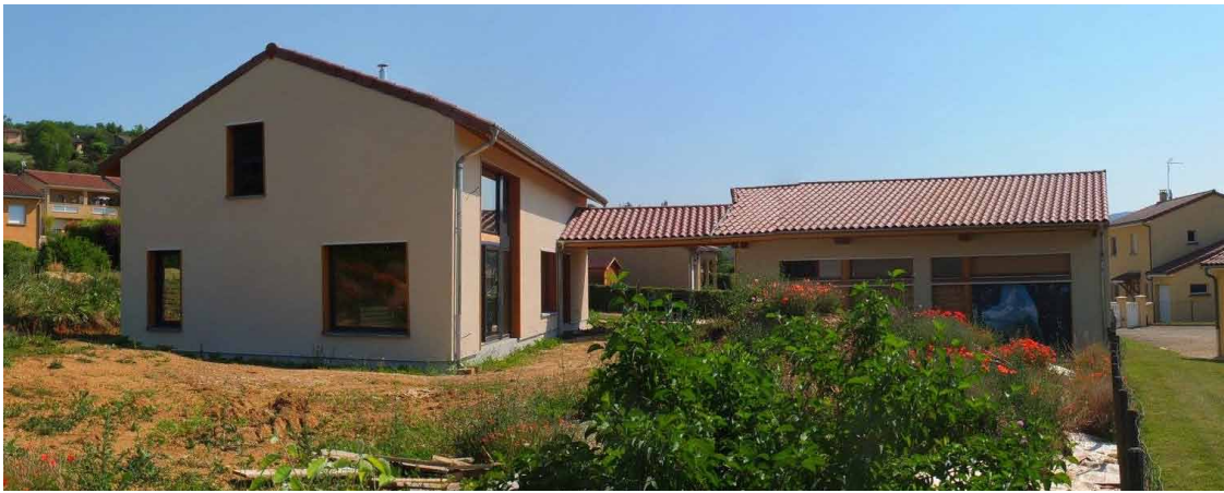
Façade sud-ouest en cours de chantier
