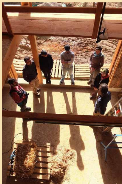
Chantier d'isolation en bottes de paille
