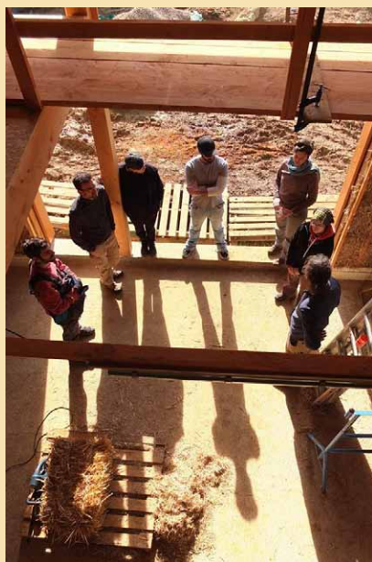
Chantier d'isolation en bottes de paille
