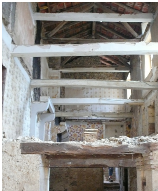
Le bâtiment pendant les travaux (mai 2011)
