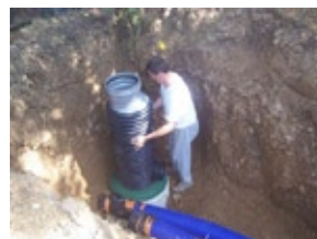
Auto-construction du puits canadien : puits d'entrée d'air, terrassement et arrivée d'air dans le local technique, où il sera connecté à la VMC.
