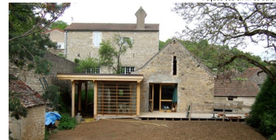
Façade sud en fin de travaux
