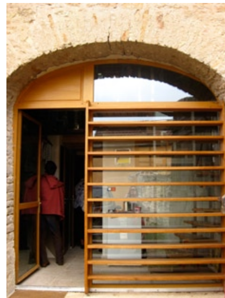
L'ancienne porte de grange devenue porte d'entrée
