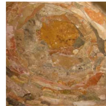
Couverture en lave vue de l'intérieur
