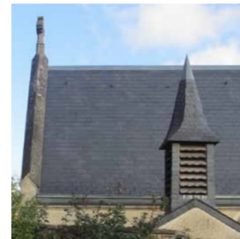
Couverture en ardoise
