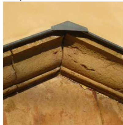
Protection d'une pierre de fronton
