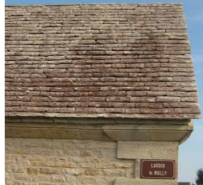
Réhabilitation de qualité d'un toit en lave
