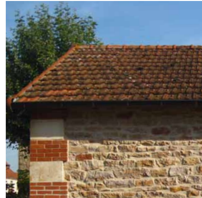
Couverture en tuile mécanique
