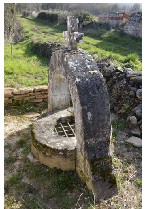
Une grille de protection horizontale est obligatoire sur les puits lorsque la margelle est inférieure à un mètre de hauteur.
