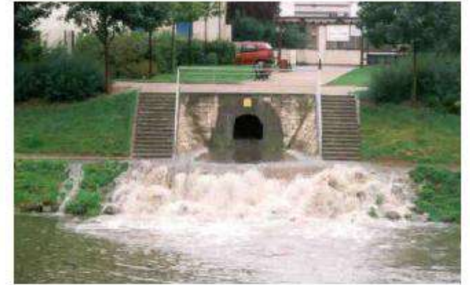
Photo 2 : Déversoirs d'orage en fonctionnement sur un réseau d'assainissement unitaire (Copyright : CETE de l'Est)
